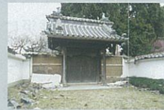
門柱の傾斜・ずれ 袖塀の破損
