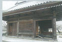
軸部のずれ・戸の脱落
