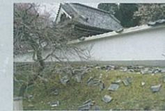
瓦の落下・壁の損傷
