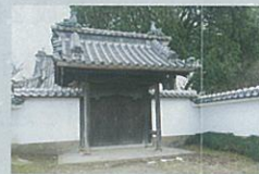
門柱の傾斜・ずれ 袖塀の破損
