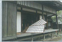
屋根の損傷・内外壁の剥離・亀裂・建具損傷
